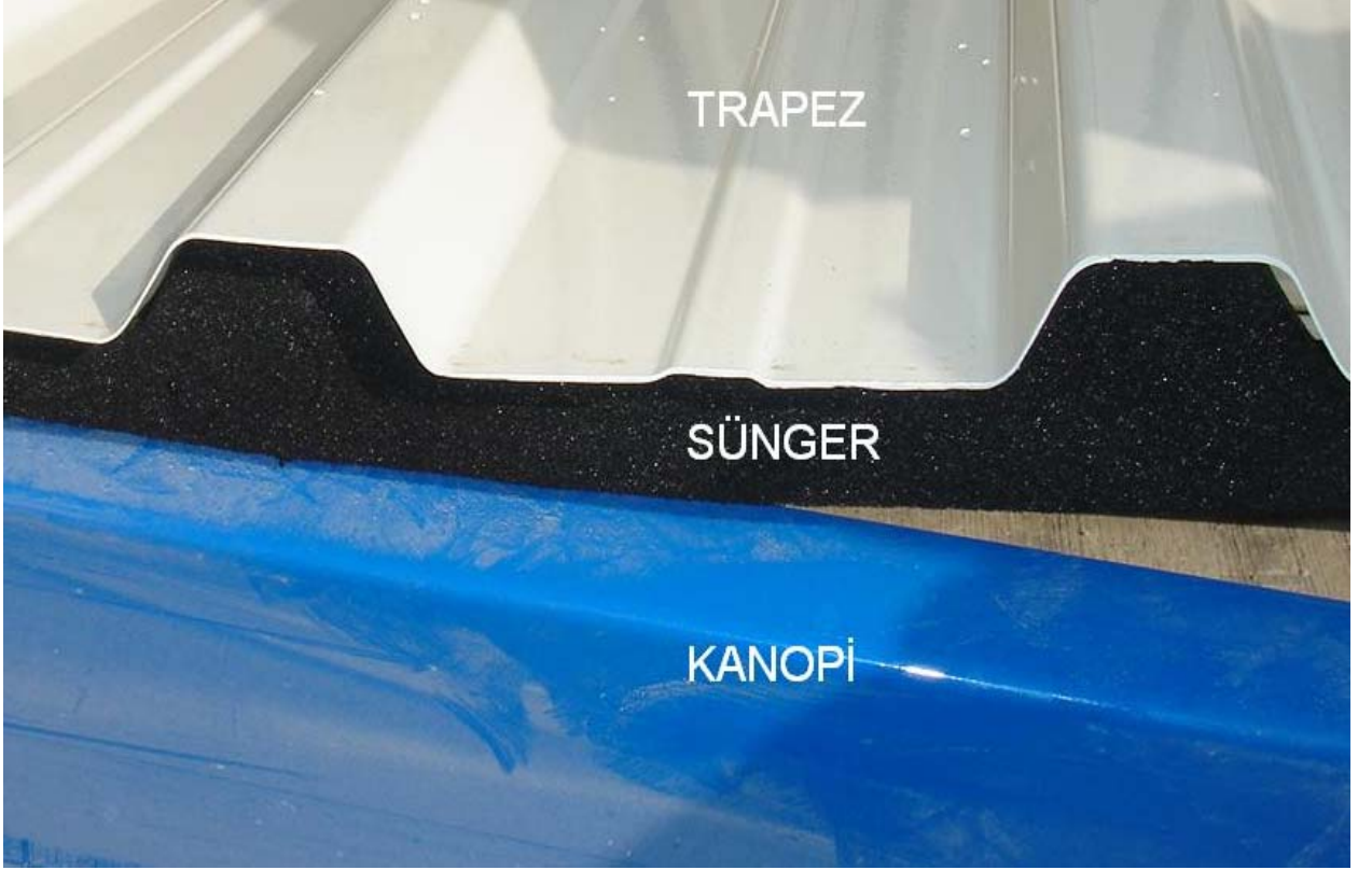
Resim 15 - Trapez levhanın kanopi ile birleştiği yerlere çatı süngeri yerleştirilir.
