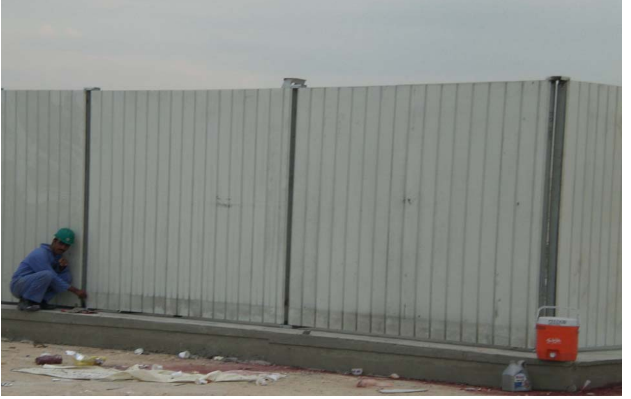
Resim 7 - Paneller projeye uygun olarak yerleştirildikten sonra alt keplerin deliklerinden çelik dübellere paneller yere sabitlenir.
