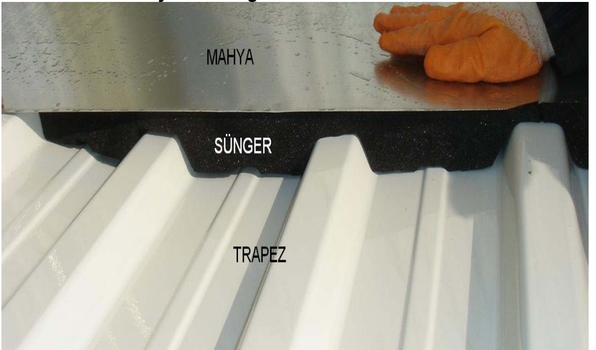
Resim 16 - Makas tepe noktasına yerleştirilen mahya ve trapez levha ile arasındaki mahya altı süngeri
