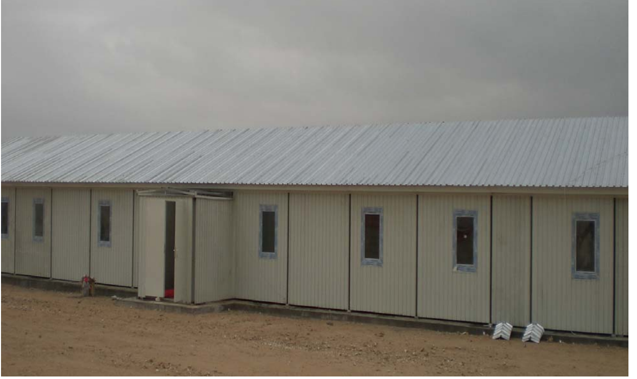
Resim 11 - Aşıkların üzerine Çatı Trapezi(27/200GLV) yerleştirilir.
