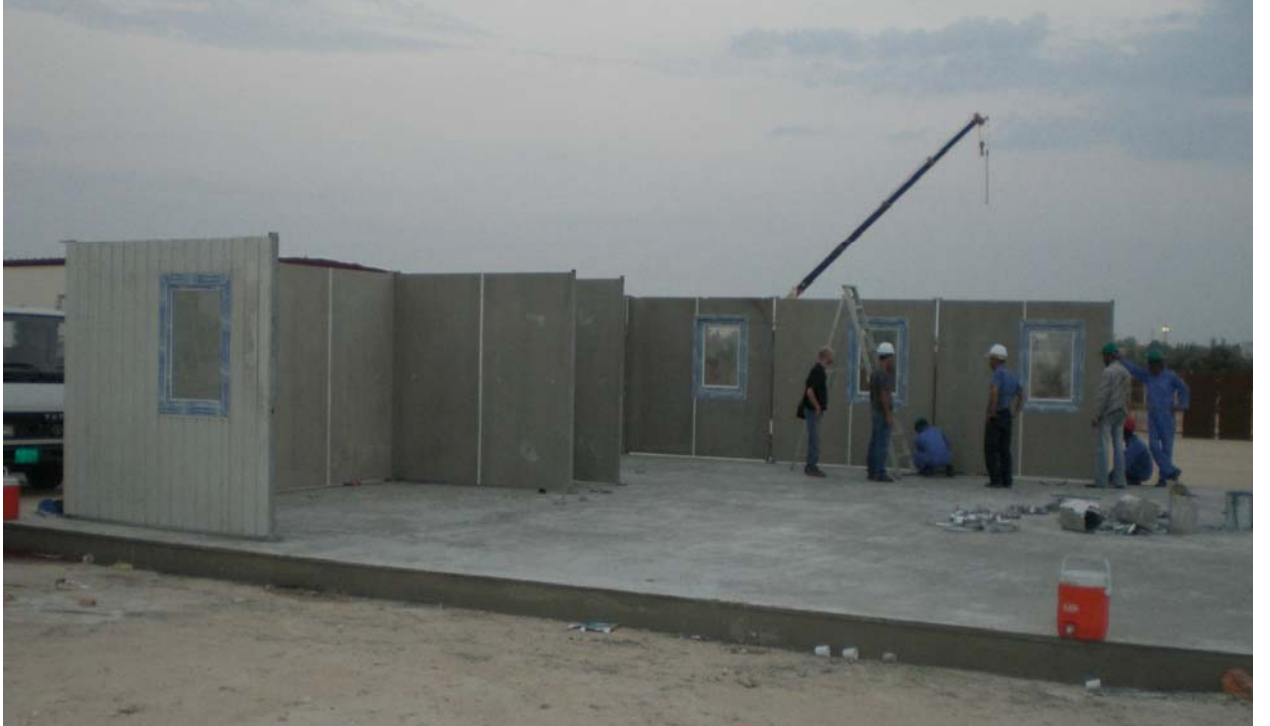
Resim 6 - Tüm paneller; uygun (2 li yada 3 lü) keplerle birbirine civatalanarak yerleştirilir.
