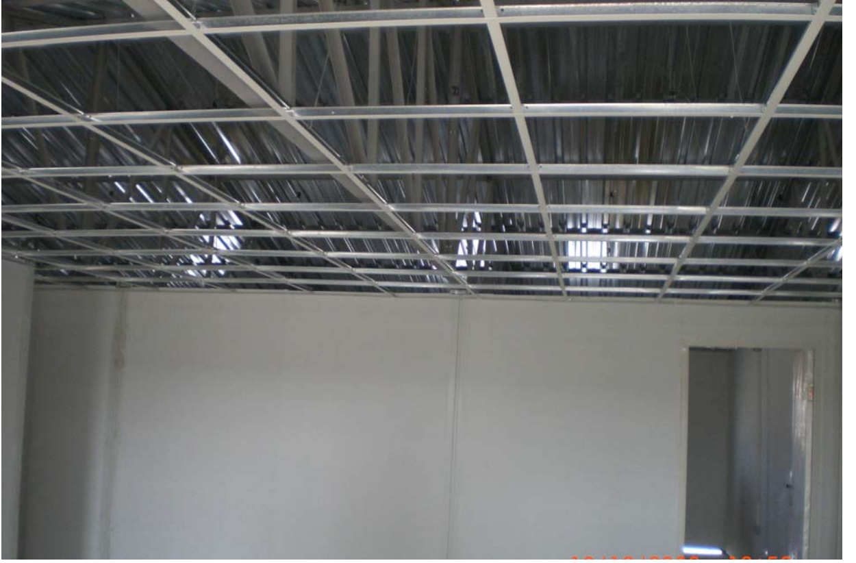
Resim 19- Taşıyıcılara yerleştirilen asma tavan malzemesi ile tavan arasına izolasyon malzemesi döşenir.
