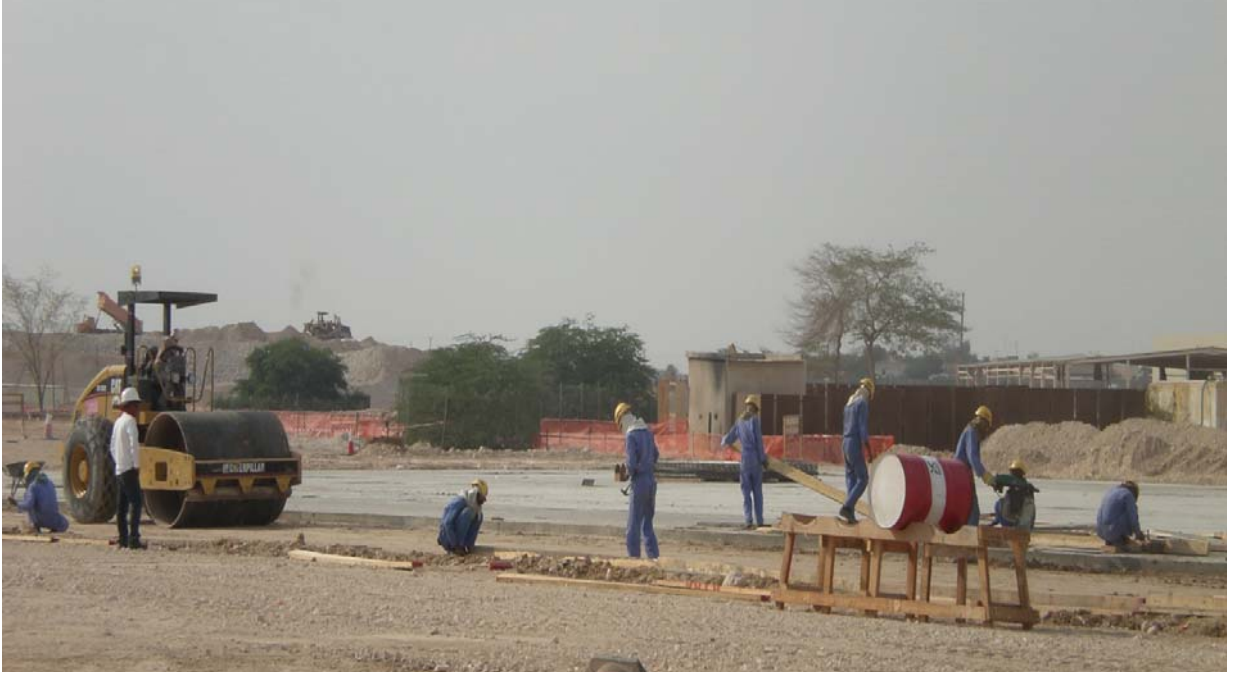
Resim 1 - Zemin Hazırlık ve Beton İşleri (Prefi tarafından beton planı verilmektedir)
