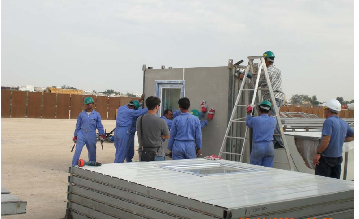
Resim 2 - Paketler açılıp paneller kuru zeminde korunarak yatırılır.
