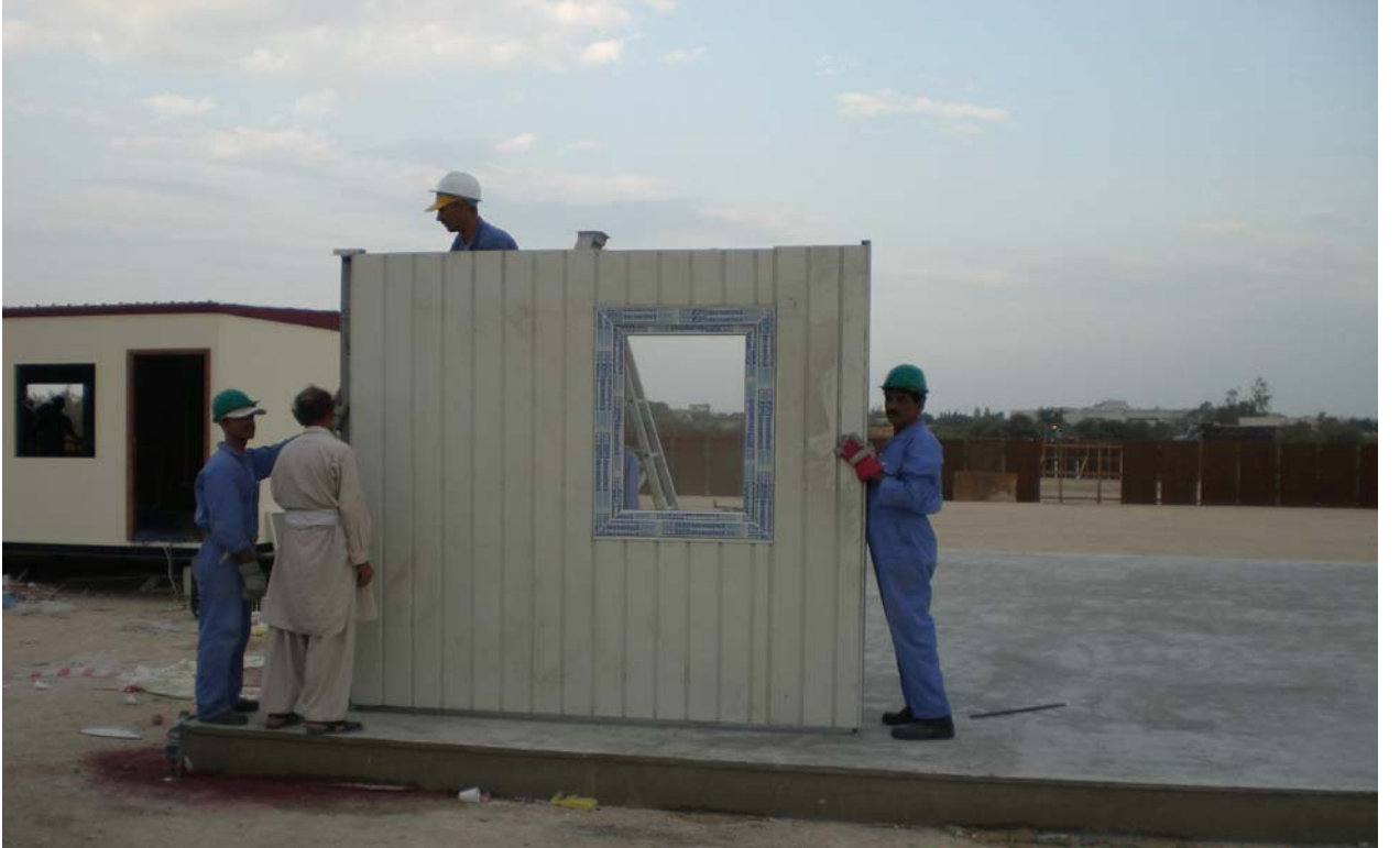
Resim 4 - Köşe Kep(L) yardımıyla iki panel birbirine kepler vasıtasıyla civatalanarak köşe oluşturulur.
