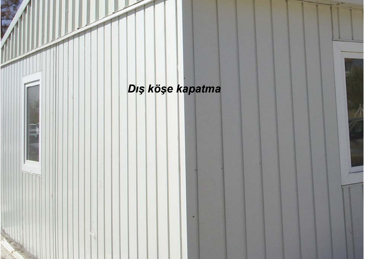
Resim 12- Dış köşe kapatmanın yerleştirilmesi
