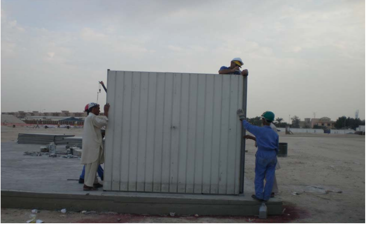
Resim 3 - Binaların BİR(1) köşesinden başlayarak ilk panel dikilir.
