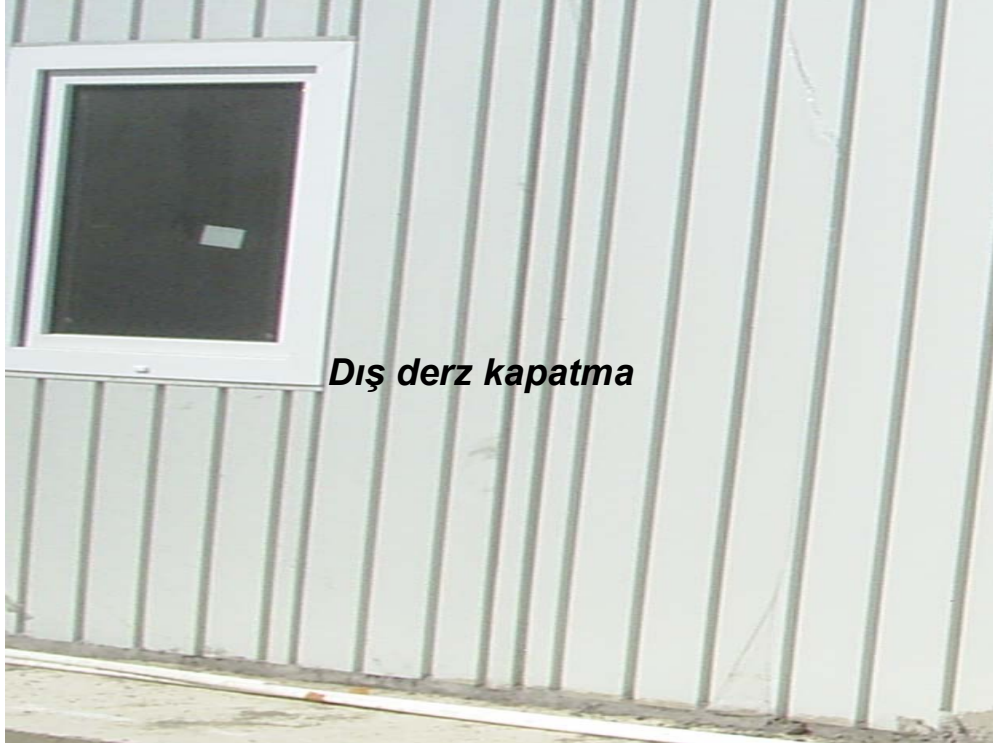
Resim 13- Dış panel birleşim boşluklarına dış derz kapatmanın yerleştirilmesi
